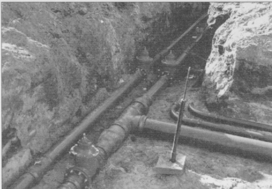
Bild 3: Versorgungsleitung mit Absperrschiebern
