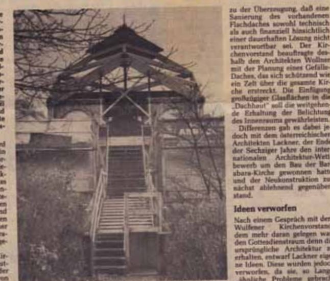
Das Regenwasser soll abfließen können: Die Spitzdachkonstruktion, mit der Architekt Lackner zunächst nicht einverstanden war. RN-Foto: Krämer
